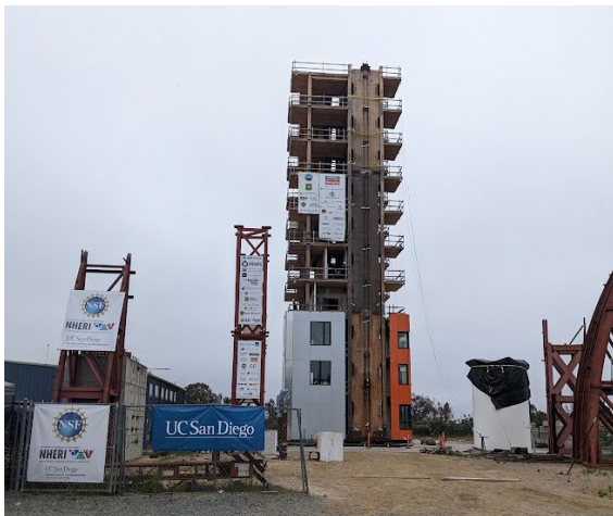
図 1 対象とした 10 階建て試験体
